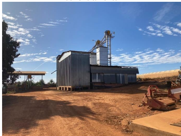
Figura 24: Estrutura de armazenamento e beneficiamento.
