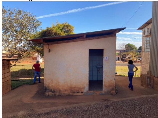
Figura 03: Banheiro dos funcionários.
