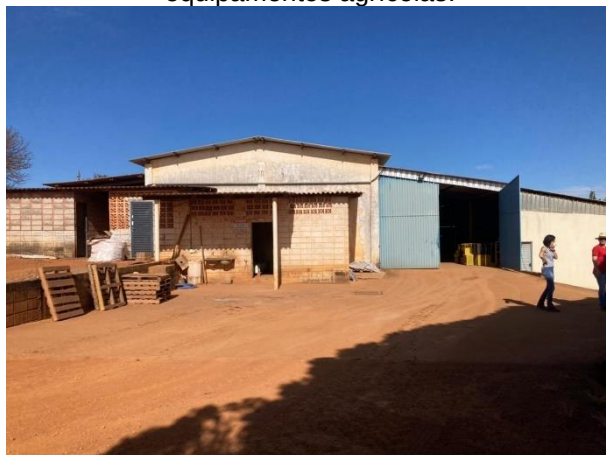
Figura 14: Barracão de armazenamento de equipamentos agrícolas.
