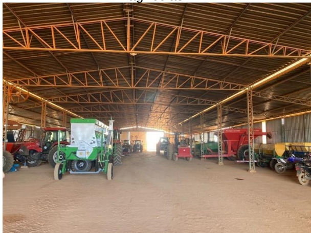
Figura 02: Barracão de máquinas e implementos agrícolas.
