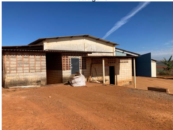
Figura 10: Salas de armazenamento de embalagens.
